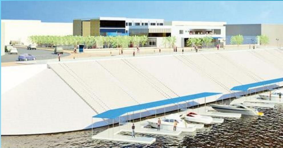
Cuenta con tres módulos o boyas flotantes, con un área de 150 metros cuadrados y tiene capacidad de atender el atraque de 10 embarcaciones simultáneamente.
